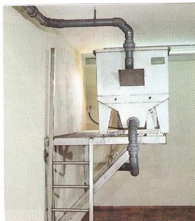
Separator: Einlauf oben, Ablauf des gefilterten Wassers unten.
